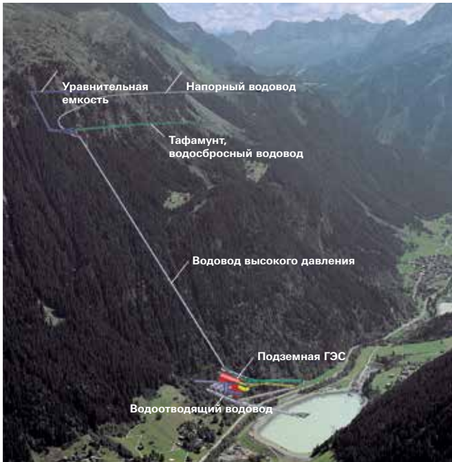
Гидроаккумулирующая электростанция Illwerke Kopswerk II (Форарльберг, Австрия).
