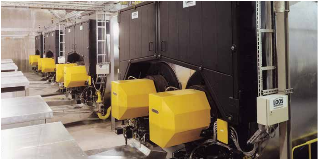
Двухжаротрубные котлы с двойными станциями KRAL.
