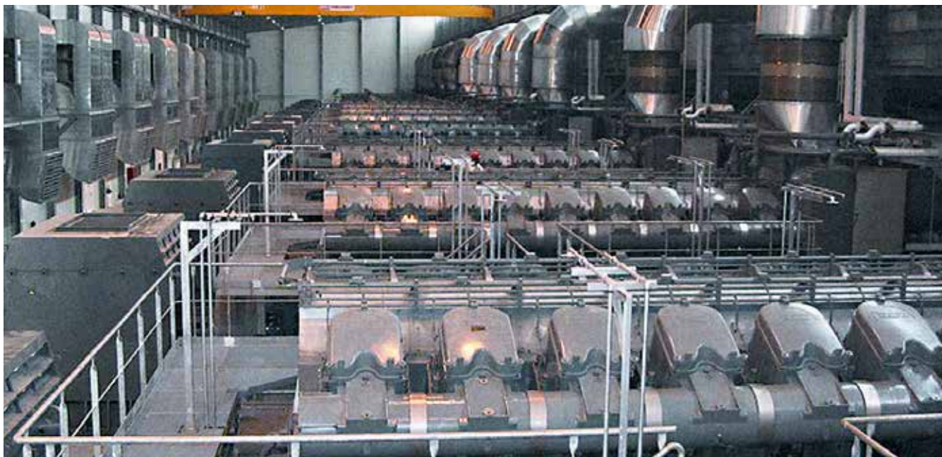
Генераторный зал с дизельными двигателями (фотография: MAN AG).
